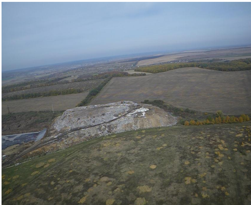
Рисунок 4 – Дергачівський полігон побутових відходів (середня висота полігону 12 м)
