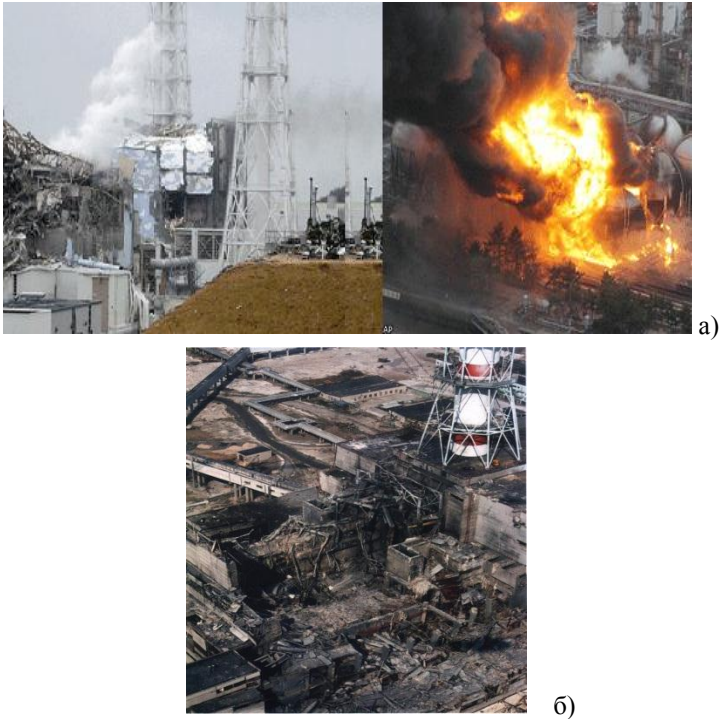
а) – Фукусима-1 (2011 р.); б) – 4-й енергоблок Чорнобильської АЕС (1986 р.) Рис. 1. Фотографії зруйнованих АЕС [12]
